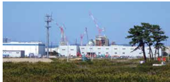
蒲生干潟側から見た建設中の石炭火力発電所 (2016年10月7日千葉永一氏撮影)
