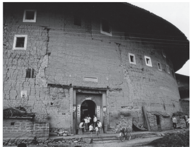
世界文化遺産にもなった福建省西部の客家の円形土楼建築。（撮影・瀬川）
