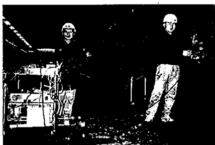
ソウルの地下鉄トンネルにおける地中レーダによる漏水検査。左が孔博士。
