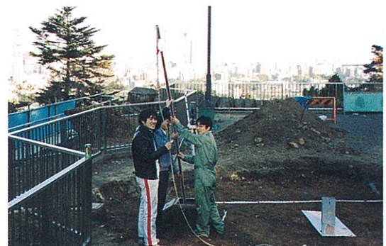
仙台城本丸跡で実施した地中レーダ実験。
