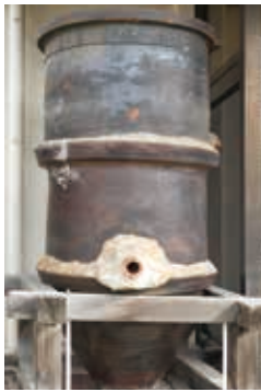
自家専用井(ここから水をくみ上げる)
